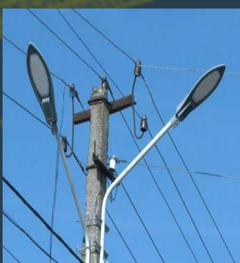
Влаштування зовнішнього освітлення.
