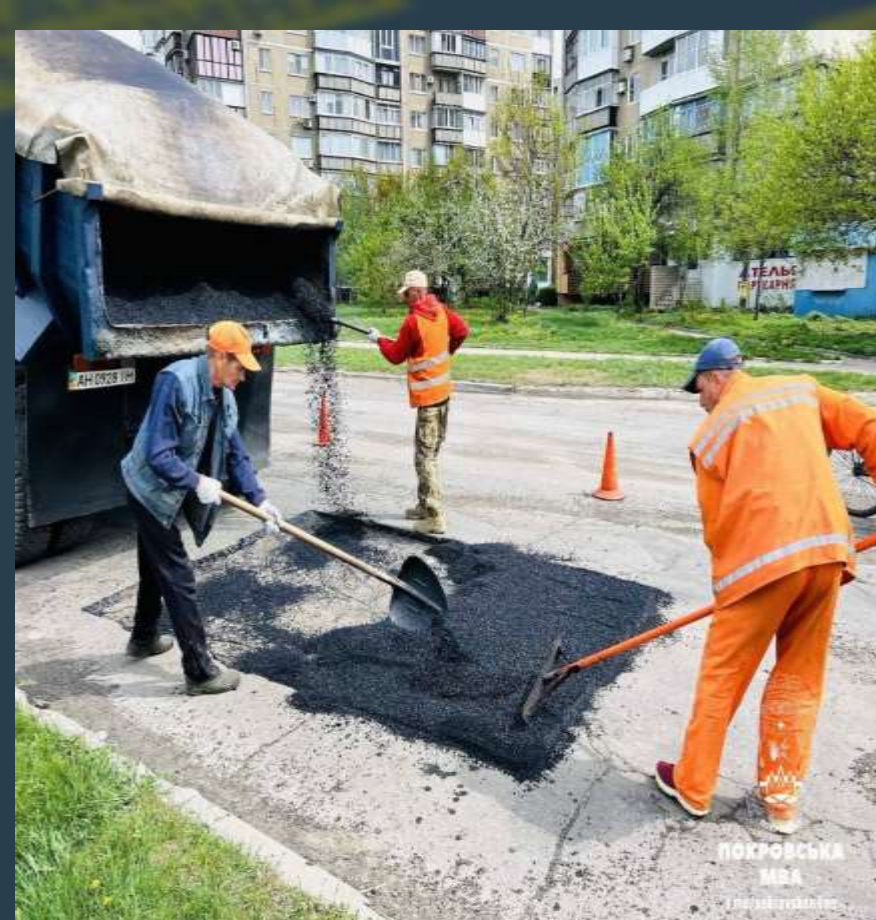
Поточний ремонт дорожнього покриття по 5 округу
