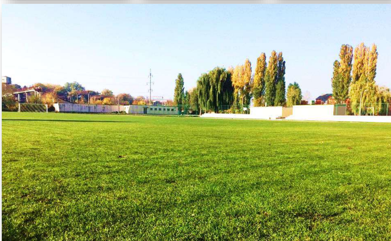
Капітальний ремонт футбольного поля стадіону Локомотив
