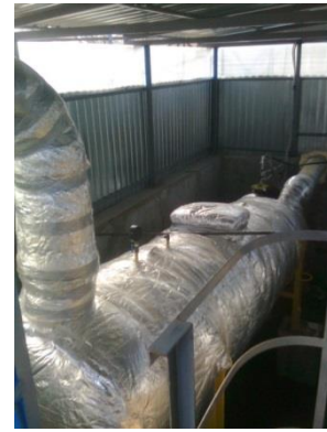
Рис.8. Загальний вигляд теплоізолюваного сепаратора.
